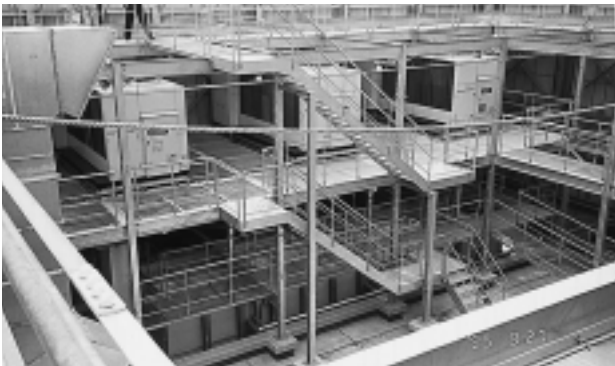
写真 - 4 屋上熱源スペース
