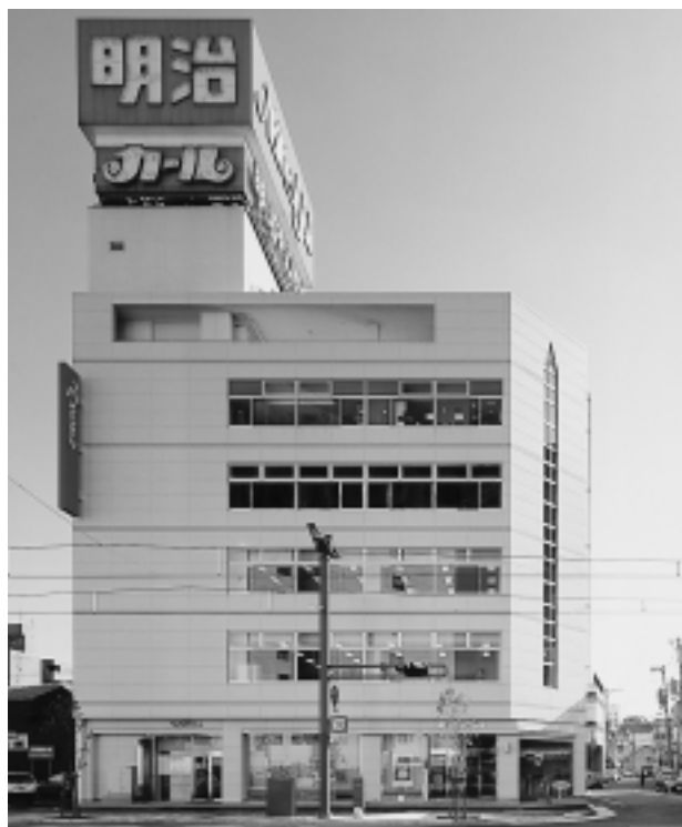
写真-1 建物外観
