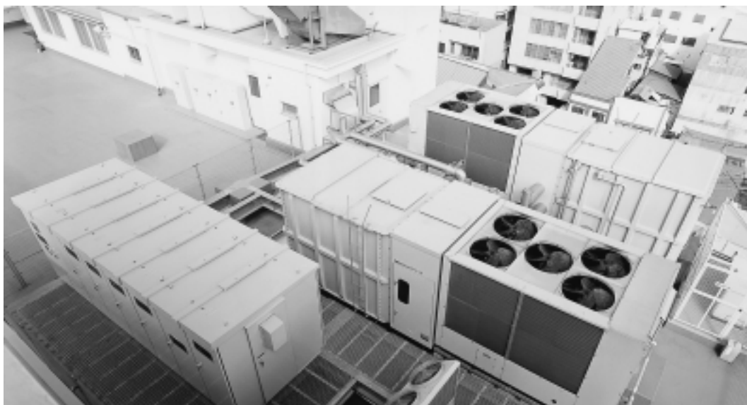
写真 - 2 屋上設置の熱源機・氷蓄熱槽
