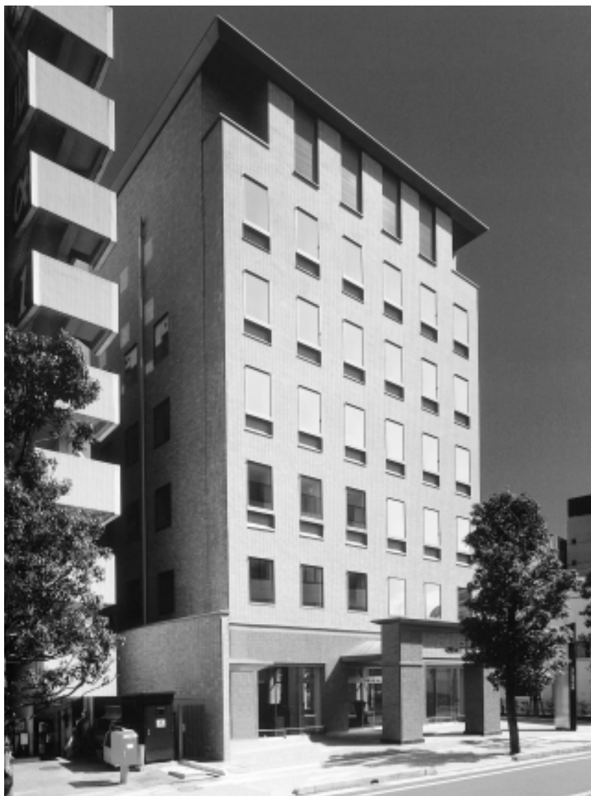
写真 - 1 建物外観
