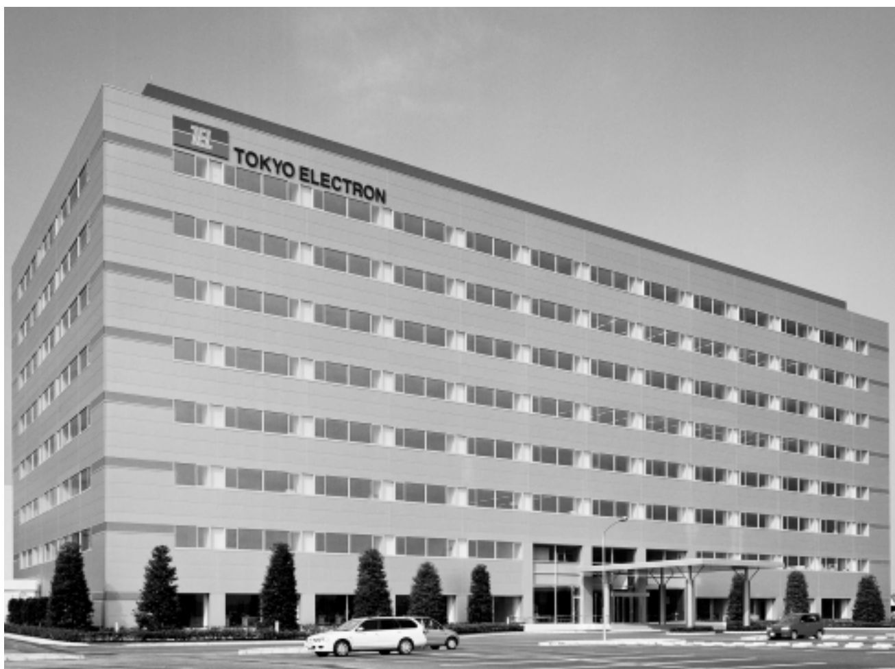
写真 - 1 建物外観
