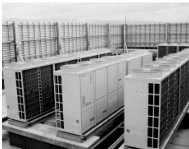
写真 - 4 屋上屋外機設置状況
