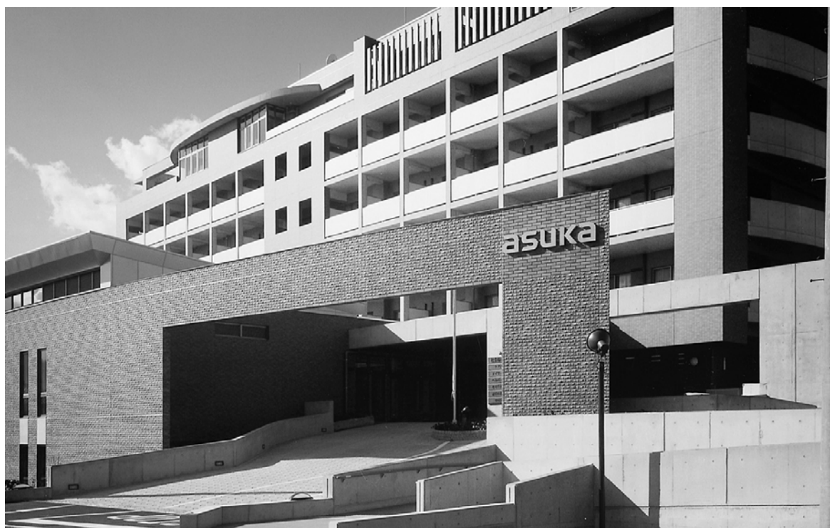
写真 - 1 建物外観
