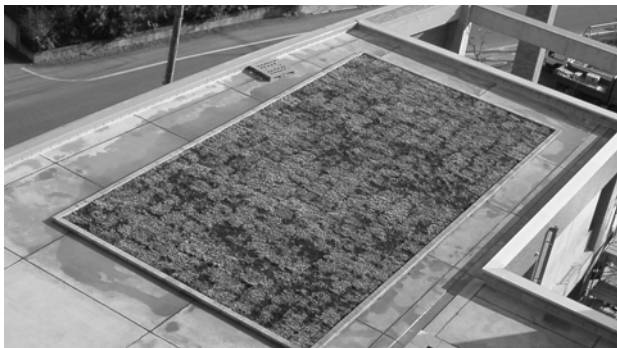
写真 - 5 屋上緑化
