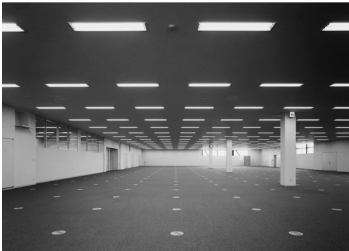
写真 - 2 オペレーションルーム(床吹き出し空調, 機器設置前)
