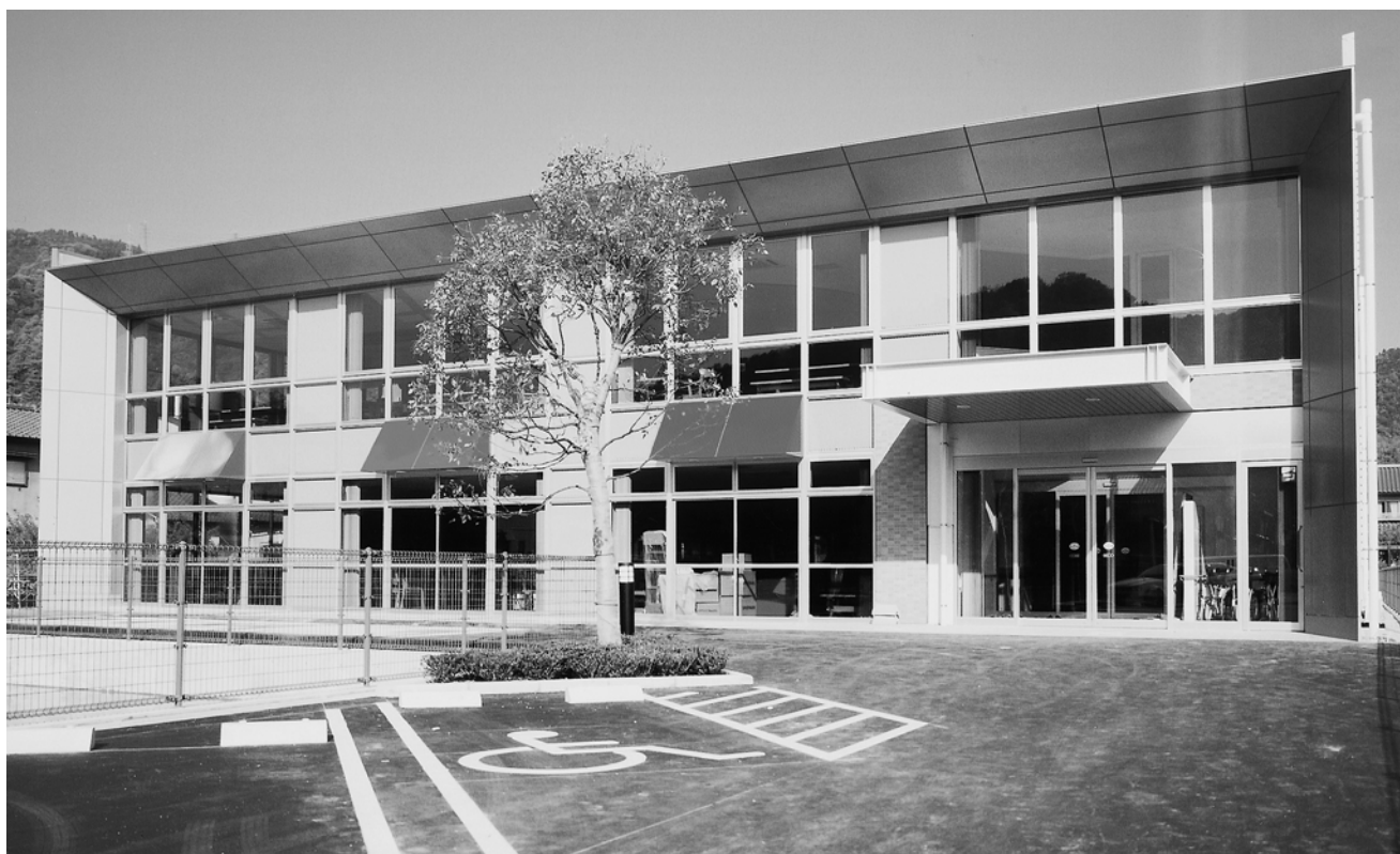
写真 - 1 建物外観
