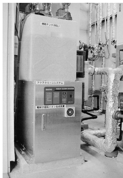
写真 - 5 電解水処理装置
