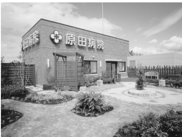
写真 - 3 屋上庭園と遮音壁
