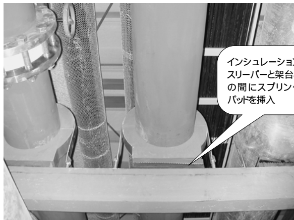
写真 - 3 配管防振施工状況
