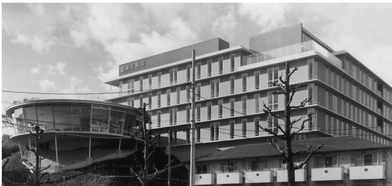
写真 - 1 病院外観
