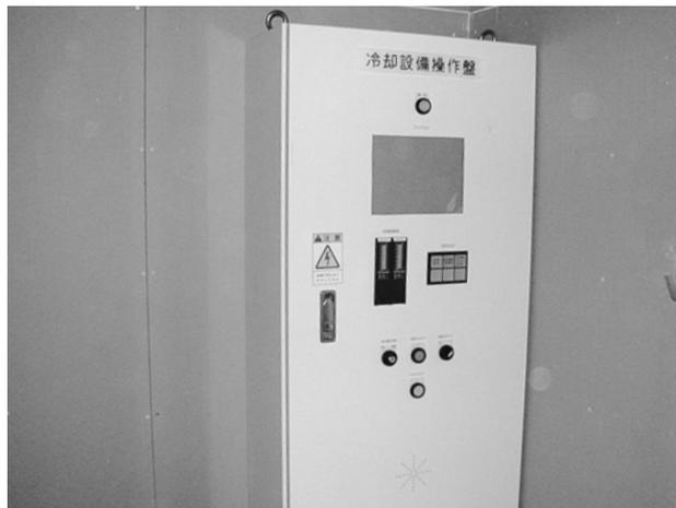
写真-4 冷却設備制御盤
