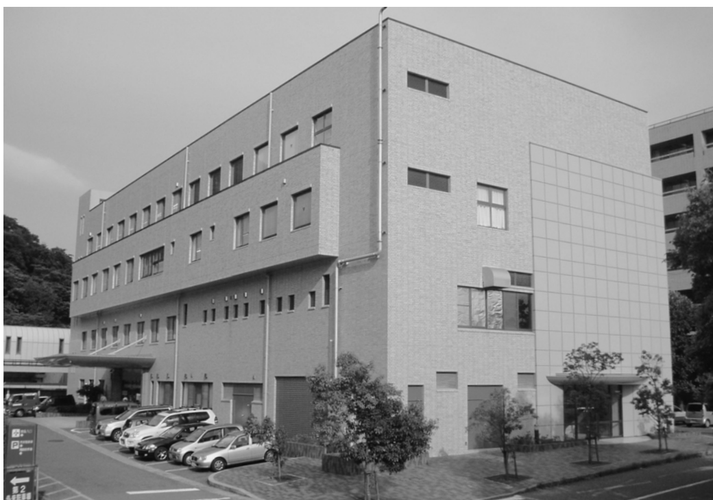
写真 - 1 建物外観
