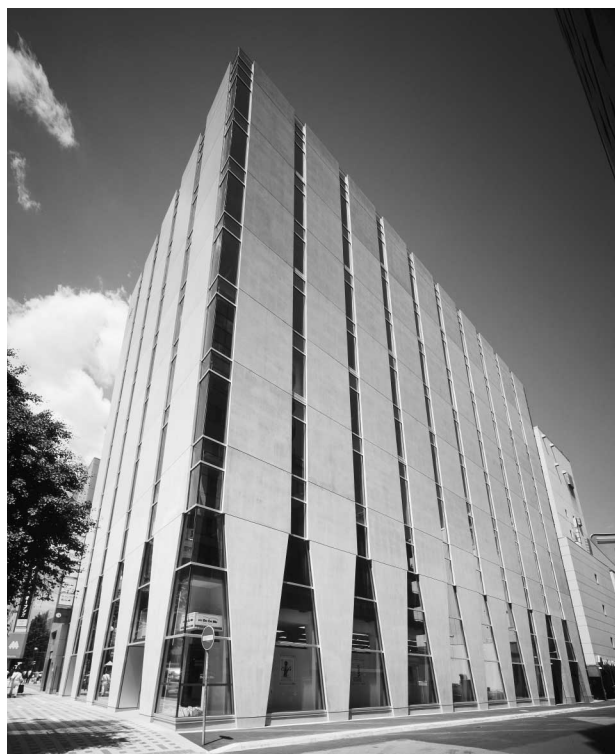
写真-1 建物全景
