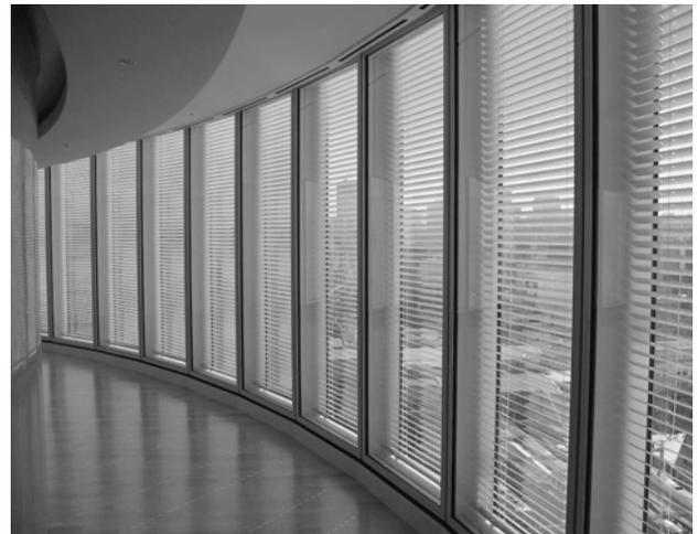
写真 - 7 全熱交換器排気通風型エアフロー
