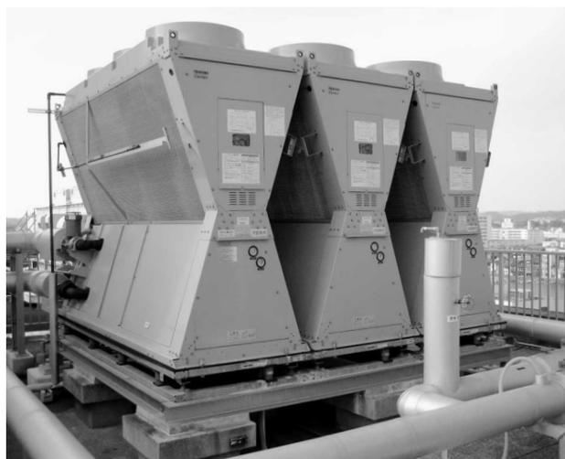
写真-2 空冷モジュールチラー
