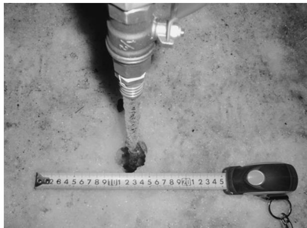
写真 - 6 落下流水による縦穴の形成
