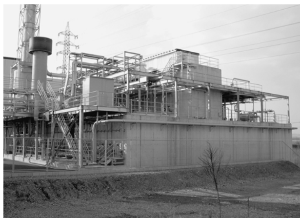
写真-5 排水処理設備
