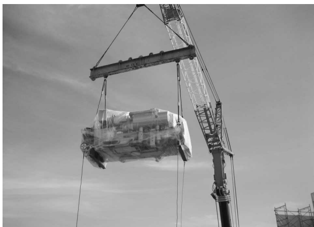
写真 - 3 ターボ冷凍機一体搬入状況
