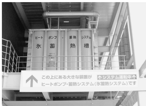
写真 - 2 氷蓄熱槽の据付状況(スロープ下部の中間階)
