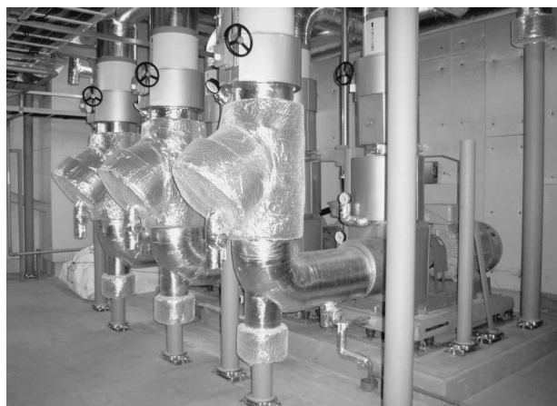
写真 - 5 ブラインポンプ据付状況
