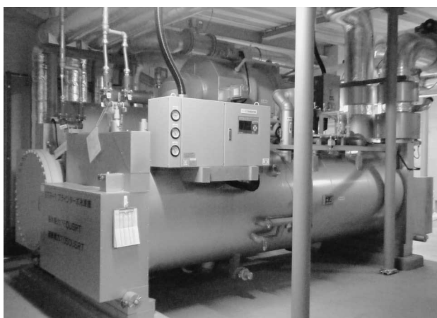
写真 - 4 BTR - 1 据付状況
