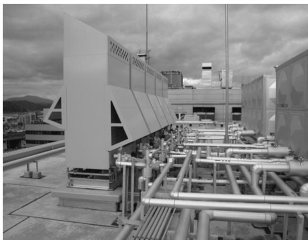
写真 - 2 屋上ヒートポンプ給湯機外観
