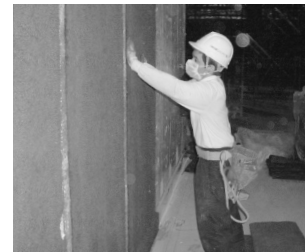
写真-6 電磁シールドフェルト取付風景
