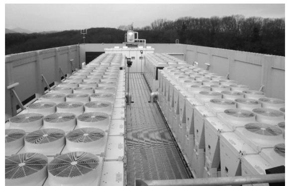
写真-2 空冷式ヒートポンプ設置状況(屋上)
