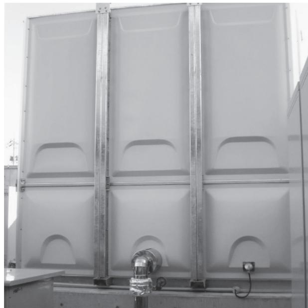
写真-3 開放式貯湯槽
