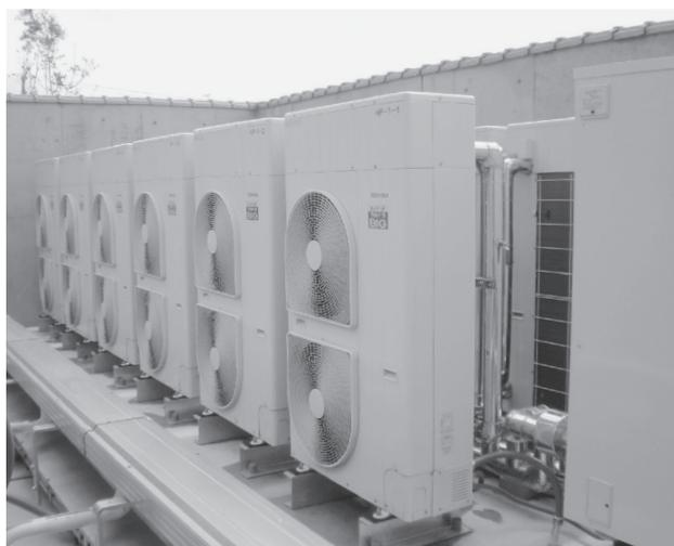
写真-2 ヒートポンプ給湯機
