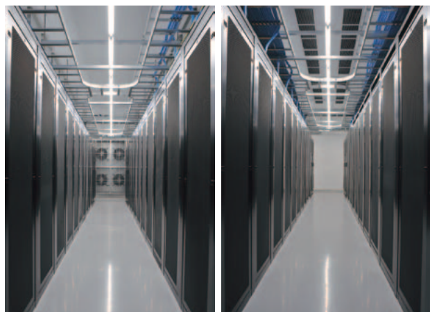
写真-4 壁吹出方式／天井吹出方式
