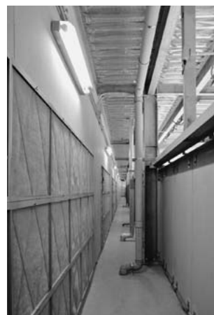
写真-5 スノートラップ、除塩フィルタ部
