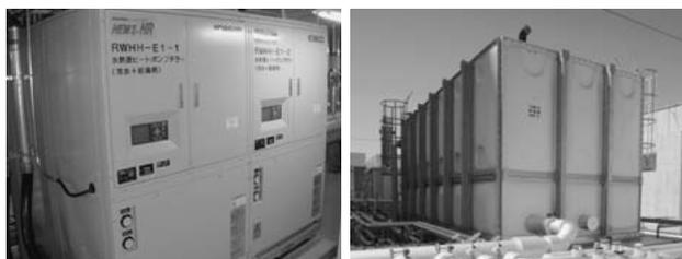
写真-7 井水熱源HP(左)と貯湯槽(50m<sup>3</sup>×2)(右)
