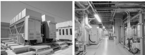
写真-6 空気熱源HPチラー(左)と井水熱利用HPチラー(右)
