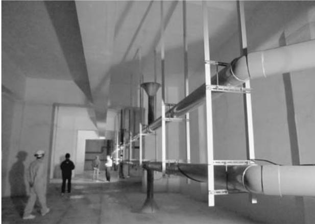
写真-5 温度成層型水蓄熱槽(2,000m<sup>3</sup>)
