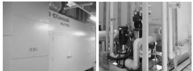
写真-2 非常用発電機(左)と井戸水の飲適ろ過装置(右)
