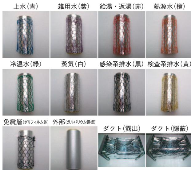
写真-15 配管・ダクトの見える化
