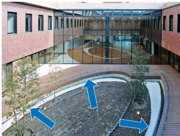
写真-5 クール&ウォームピット用外気取り込み口
