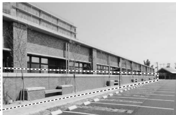
写真-4 煉瓦調タイルによる浸水防止壁
