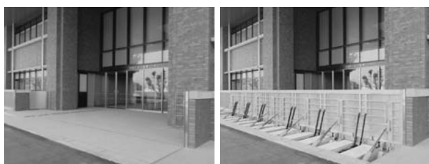
写真-3 防潮板の設置状況
