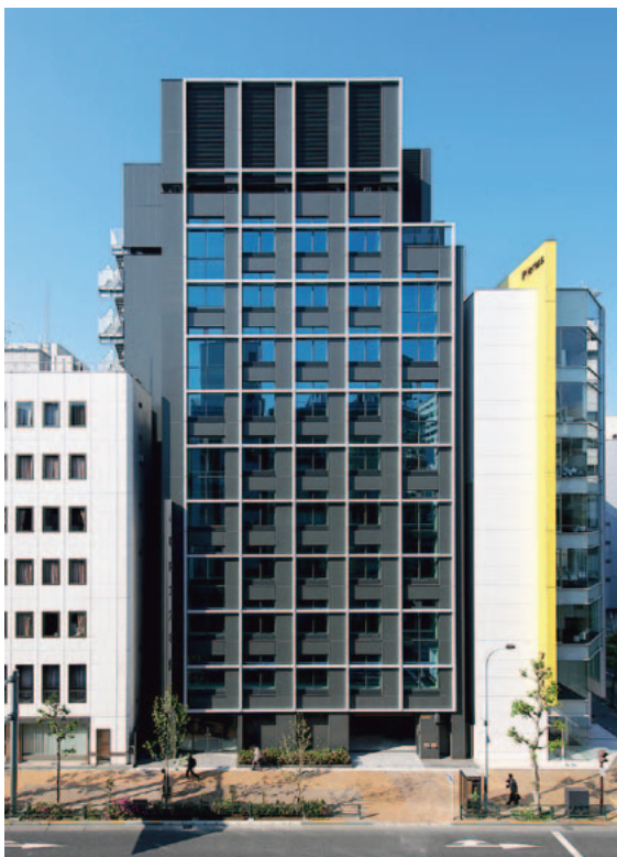
写真-1 建物外観
