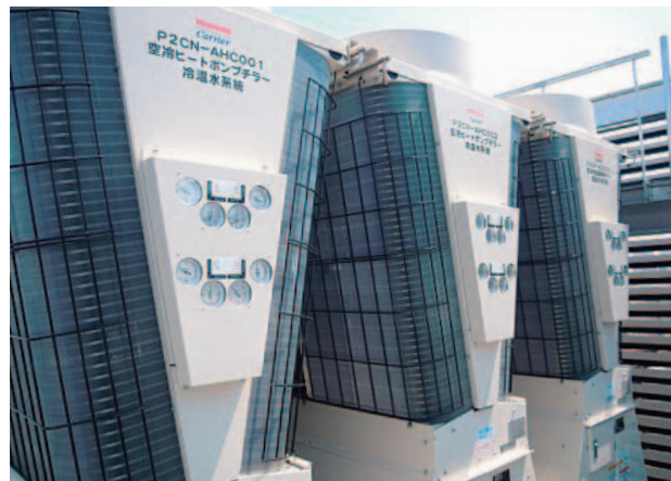
写真-3 空気熱源ヒートポンプチャラー
