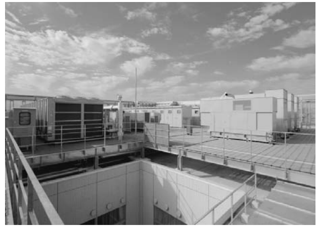
写真-3 建物屋上
