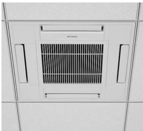
写真-3 システム天井用天井カセット型室内空調機
