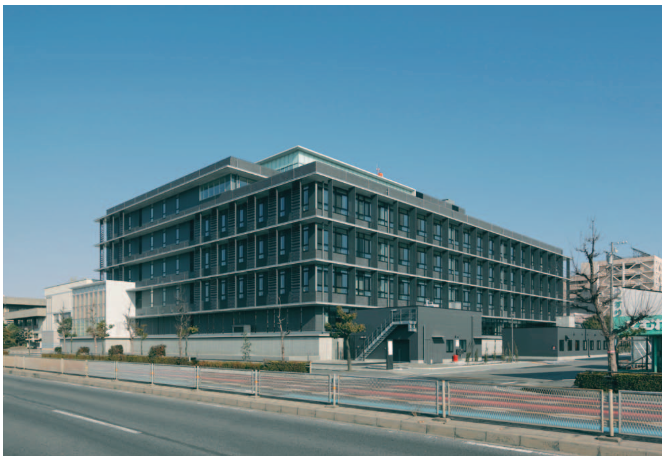
写真-1 建物外観(南西方向より)
