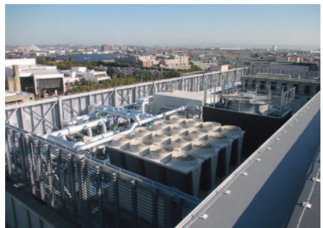
写真-3 屋上熱源機械置場(空気熱源モジュールチラー，吸収式冷温水発生機，冷却塔)
