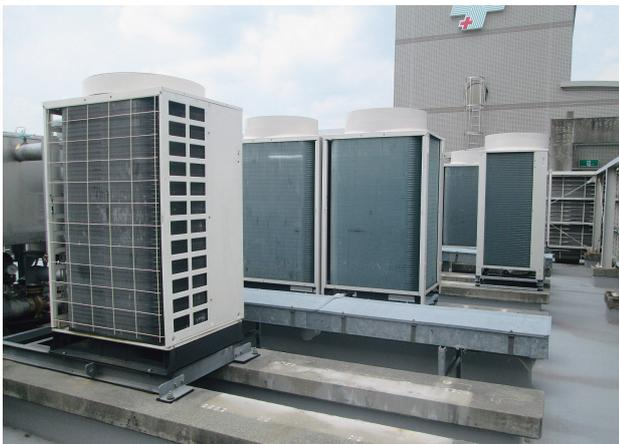
写真-7 空気熱源ヒートポンプエアコン室外機
