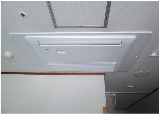
写真-6 空気熱源ヒートポンプエアコン室内機
