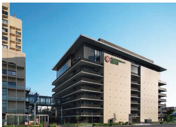
写真-4 健診センター外観
