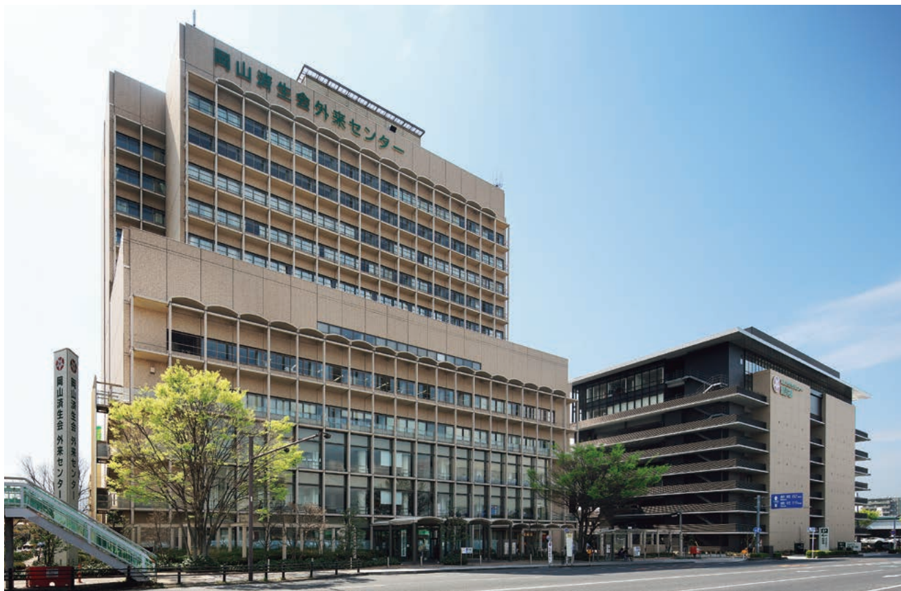
写真-1 建物外観
