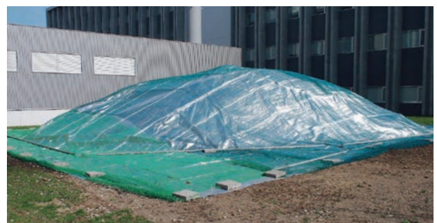
写真-5 堆雪場のシート養生
