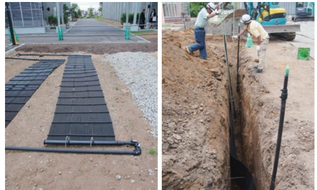
写真-3 S-HEX敷設状況
