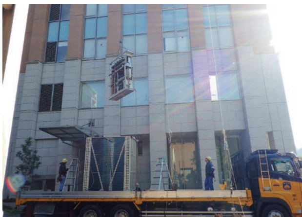
写真-4 機器揚重作業
