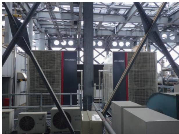
写真-6 機器設置完了
