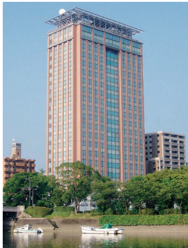
写真-1 建物外観
