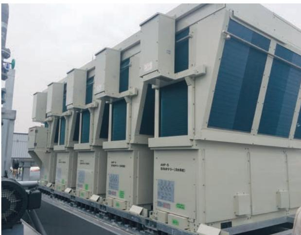
写真-2 空冷ヒートポンプモジュールチラー
