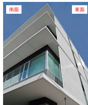
写真-3 建物南東角外観
