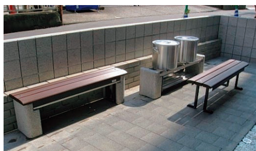
かまどベンチ (非常時の炊き出し用: 2基設置)
