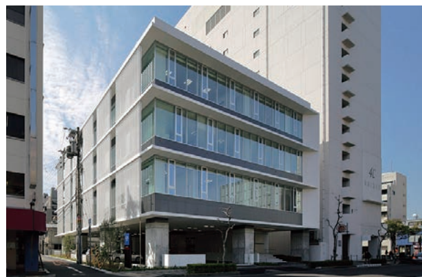
写真-1 建物全景
