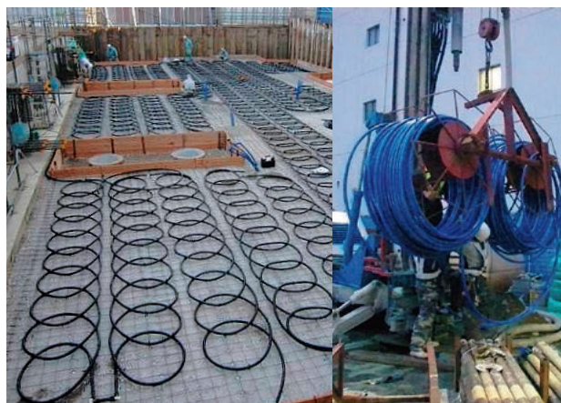
写真-6 地中熱利用(水平コイル方式とボアホール方式)
