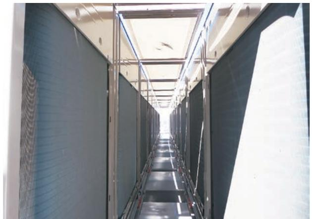
写真-7 室外機設置状況
