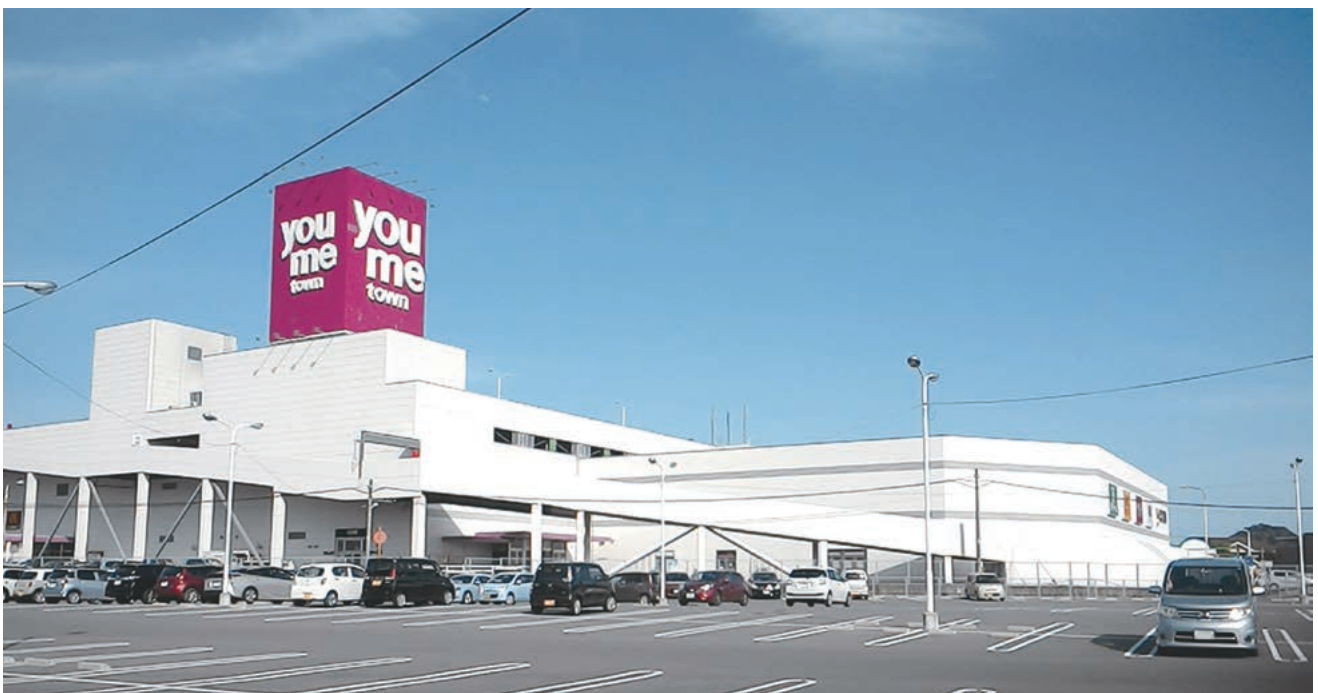
写真-1 建物外観
