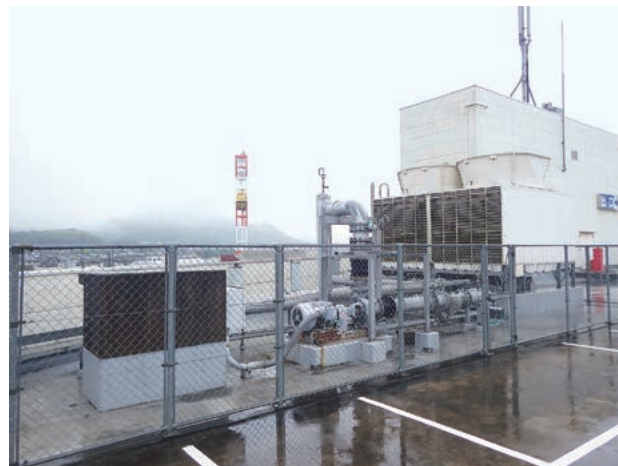
写真-2 既設冷却塔設備
