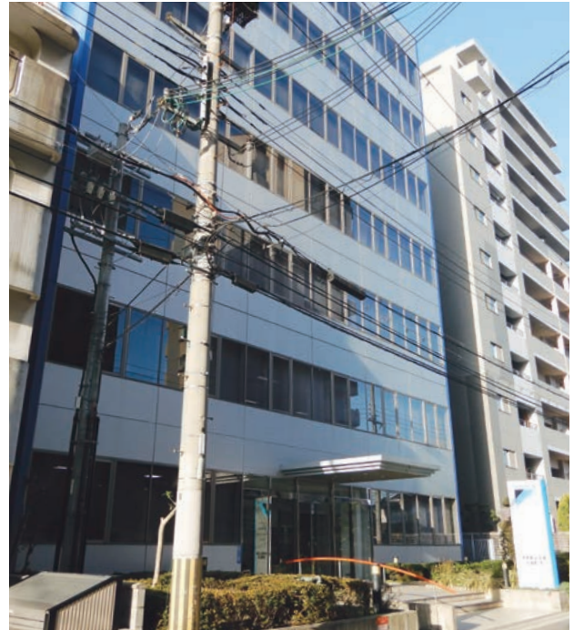
写真-1 建物外観
