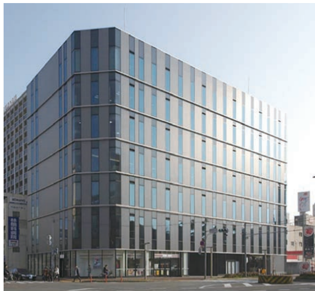
写真-1 JS博多渡辺ビル外観
