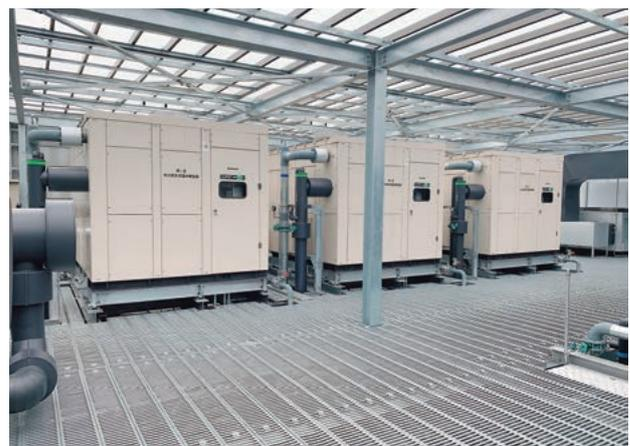
写真-3 ガス焼き二重効用冷温水発生機
