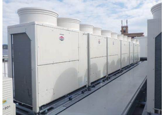
写真-3 空気熱源ヒートポンプエアコン(ビル用マルチ)
