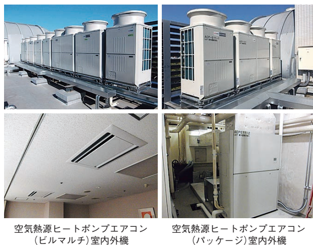
写真-5 ビルマルチエアコン、パッケージエアコン
