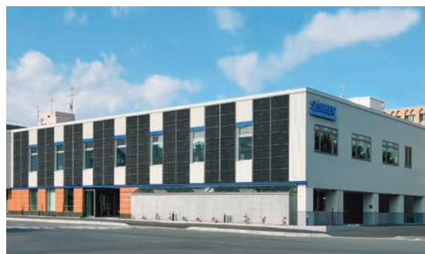
写真-1 建物外観
