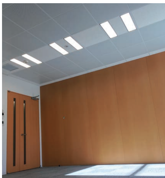
写真-4 応接室(空気式天井放射)
