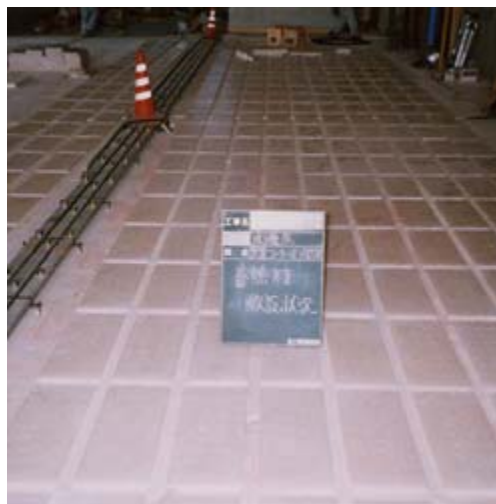
タイル敷設工事写真
